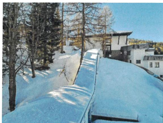
Derzeit noch bestehender Verbindungsgang
